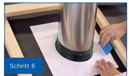
Abdichtmanschette mit Putzträger 7°-35° für Abgasleitungen bis T200 und Klebekragen
