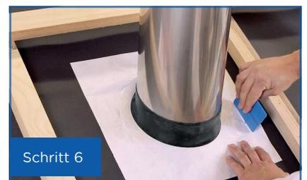
Abdichtmanschette mit Putzträger 7°-35° für Abgasleitungen bis T200 und Klebekragen
